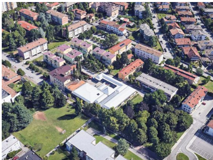
Villaggio San Domenico oggi
