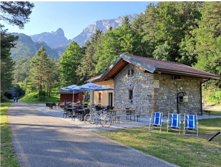
Il casello dopo il restauro
